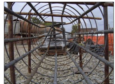
CPT&I - Rebar Cage
