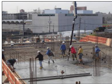
CPT&I - Concrete Slab Pour
